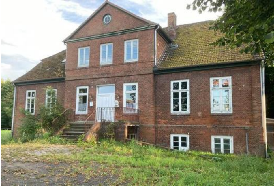
Bild 1 Gutshaus Riepenburg Zustand heute
